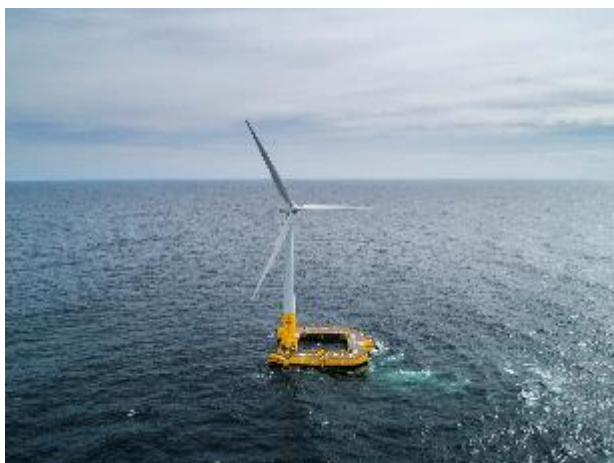
Figure 2 - Eolienne flottante installée par BW Ideol.
