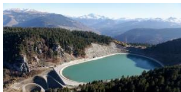
Figure 15 – Site de la STEP de la Coche située en Savoie (France).
