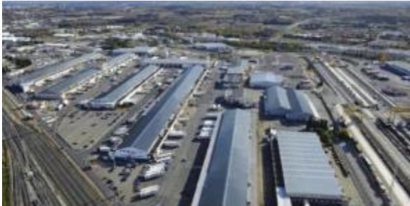
Figure 7 - Marché de Saint-Charles à Perpignan (Akuo) : La plus grande centrale photovoltaïque intégrée en toiture au monde à sa date de mise en service en 2011.
