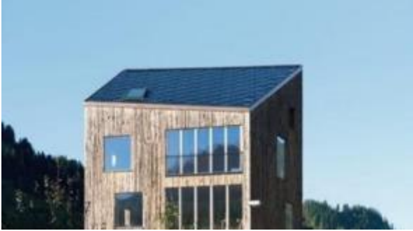
Figure 6 - Réalisations photovoltaïques de nature collective ou individuelle (©n11 architekten gmbh).
