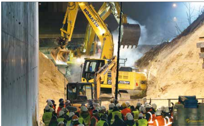
Le bal des pelleteuses qui s'activent pour faciliter le ripage de l'énorme pont-rail en béton armé.
