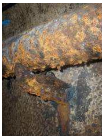
Rue Saint Jacques (support à changer)
